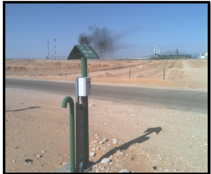
Figure II.7. Protection cathodique par courant imposé
