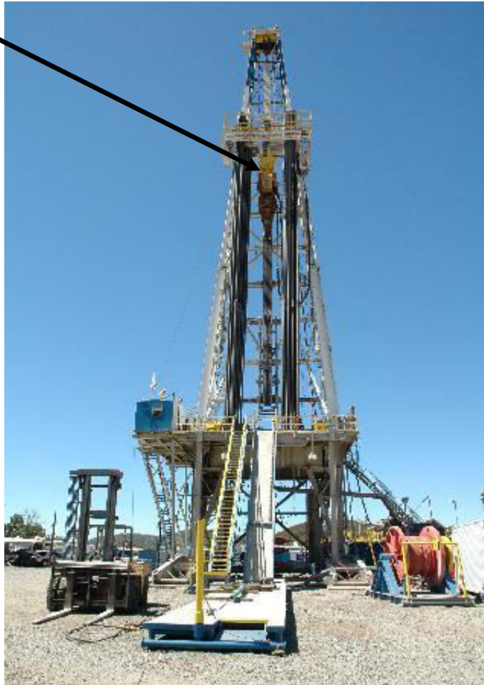
Figure (I-3) forage par le Top Drive
