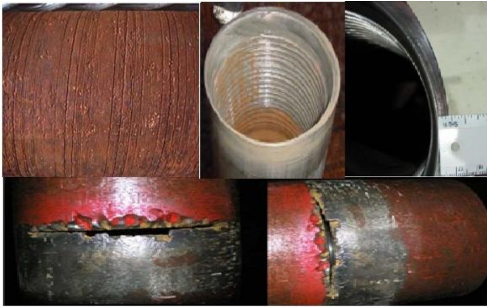
Figure (III.10) : Endommagement de protecteur.
