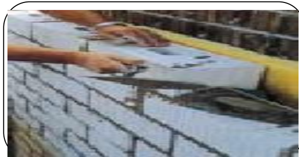
Figure I.19 Mur en brique silico-calcaire [6].
