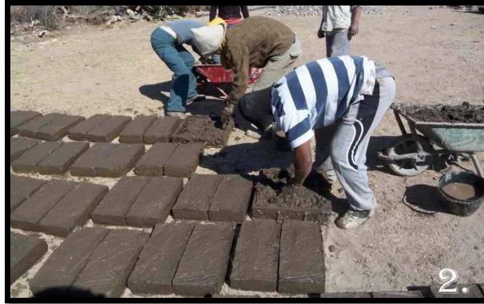
Figure I.1 : Moulage et séchage des blocs adobes [9, 10,11]
