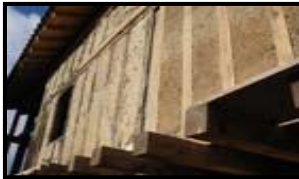
Figure. I.7 : Mur en torchis [5]
