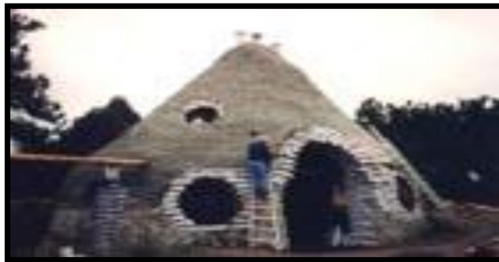
Figure. I.11 Mur en sacs de terre [6]
