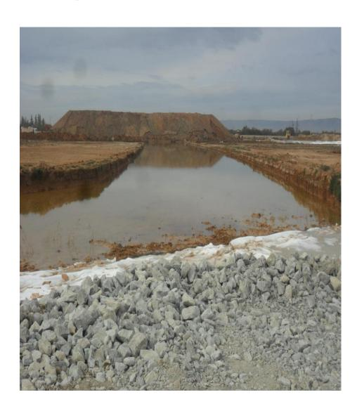
Le tracé en remblai, parcourt deux zones formées par des terrains très imperméables, potentiellement inondables et sur lesquelles l'eau s'accumule en cas de débordement de **Oued Boussilte** ou en cas de forte pluie.
