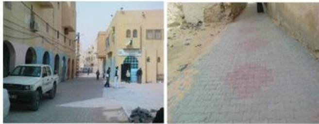
الصورة رقم: 3 و 4 تهيئة الشوارع والدروب داخل القصر
