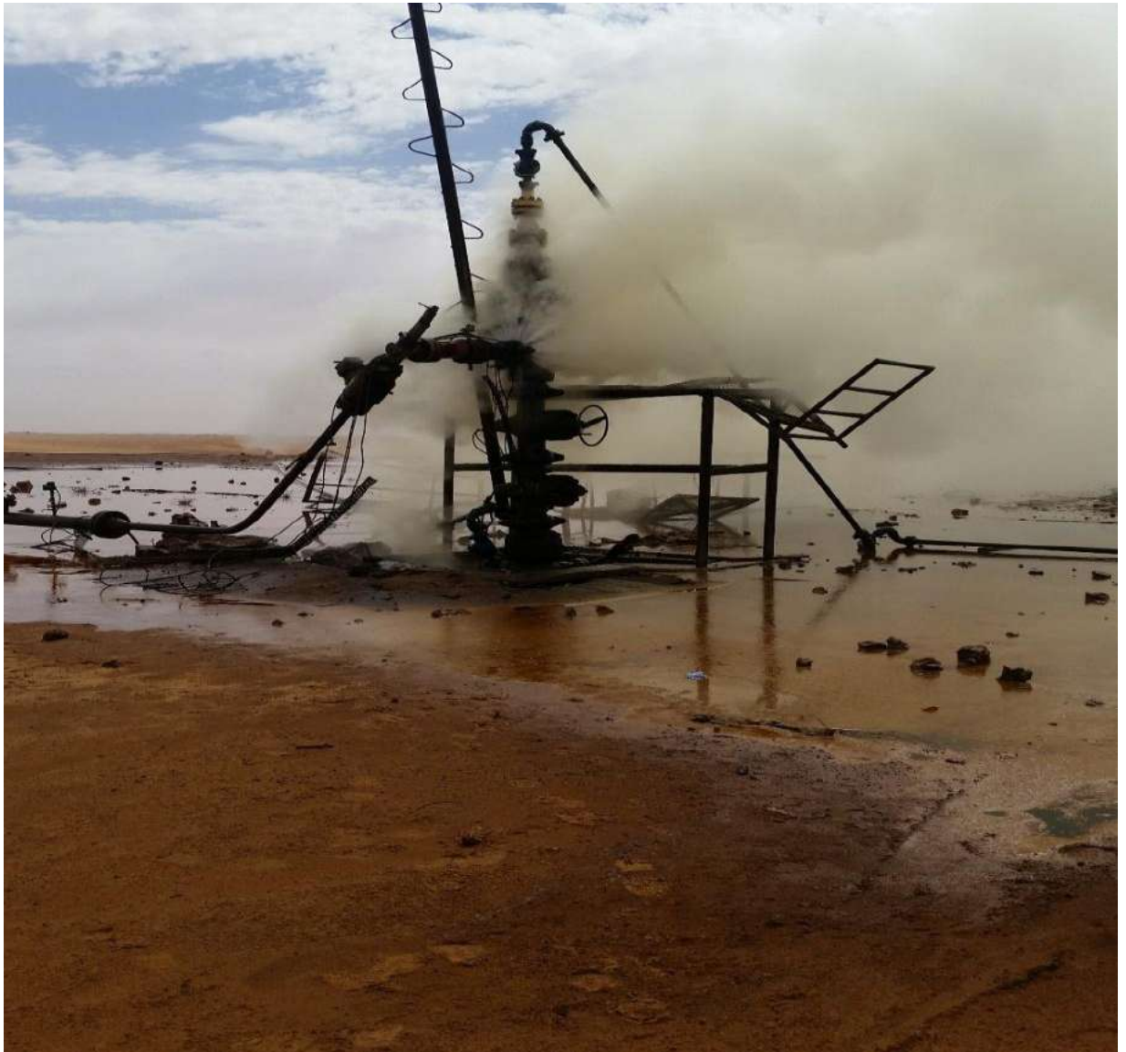
Figure II.1 : LES FUITES DE Puits OMN-42
