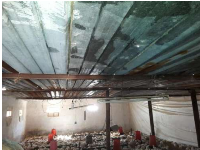
Figure 11: Toiture en zinc ondulé chez l'éleveur BELCO.
