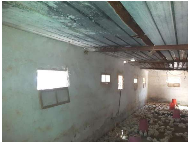
Figure 16 : Ventilation statique en élevage semi traditionnel.
