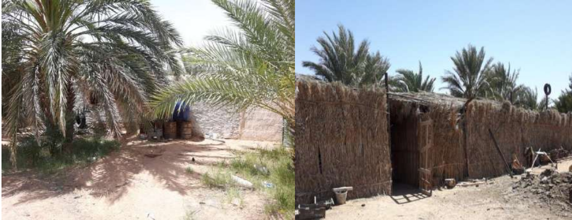
A : bâtiment avicole en parpaing B : bâtiment en palmes sèches.
