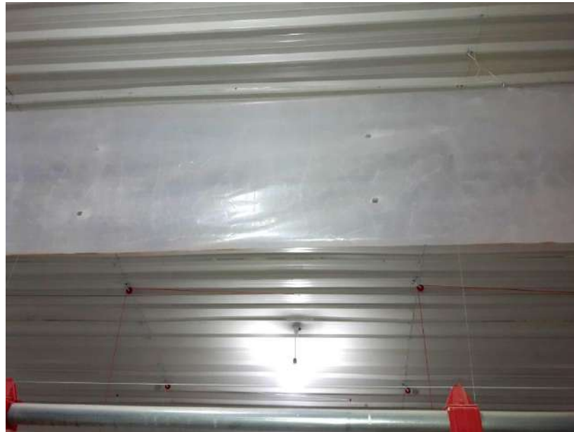
Figure 12: Toiture en panneaux sandwich chez BAYAT.
