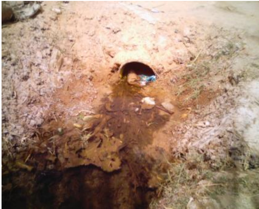
الصورة 4.وضعية خنادق الصرف بمحطة الشط
