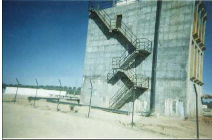
شكل 4. مبرد المياه المستعمل بمنطقة عين الصحراء
