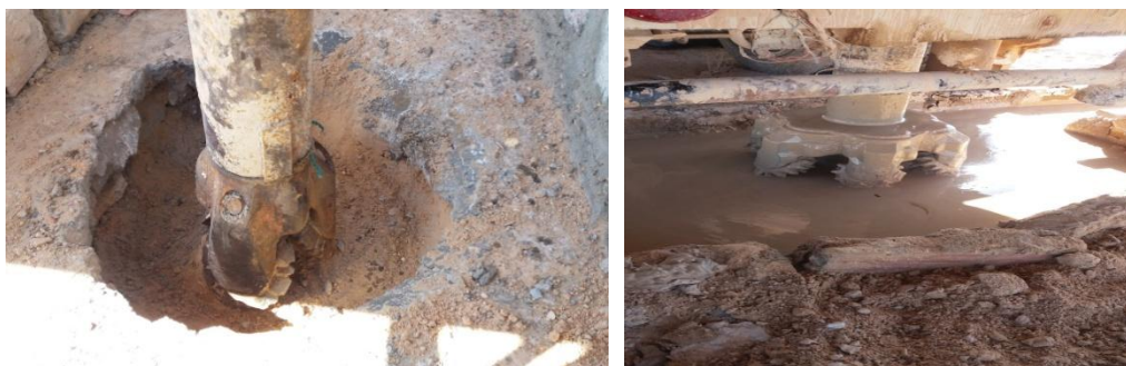
Fig.33 :l'outil de forage 12'' 1/4 et 24''
