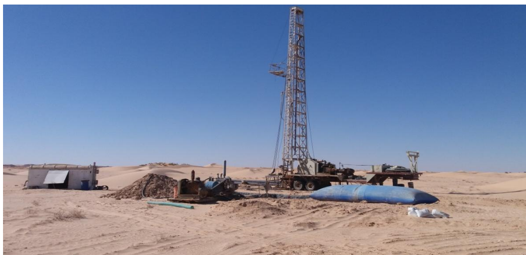
Fig.31: installation de chantier de forage
