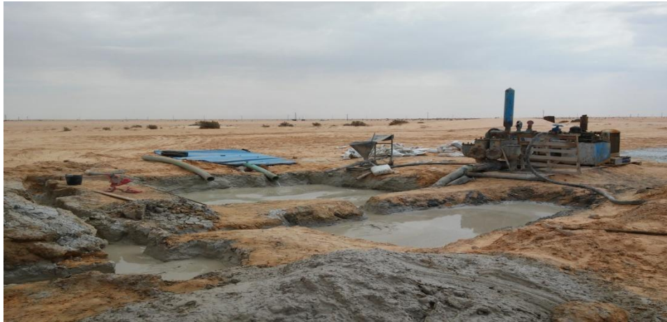
Fig.44 : lavage de puits ajouté à l'eau claire
