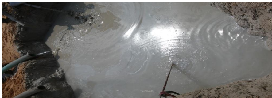
Fig.36: Préparation le lait de ciment
