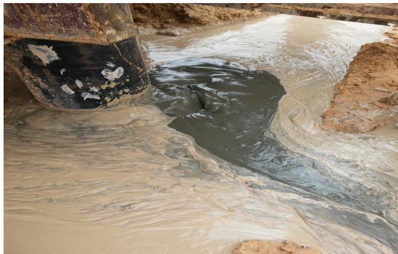
Fig.38 : Cimentation le deuxième parti
