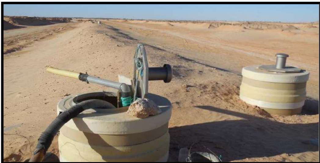
Photo 2 : Regard sur le canal utilisé pour le pompage des eaux usées épurées.
