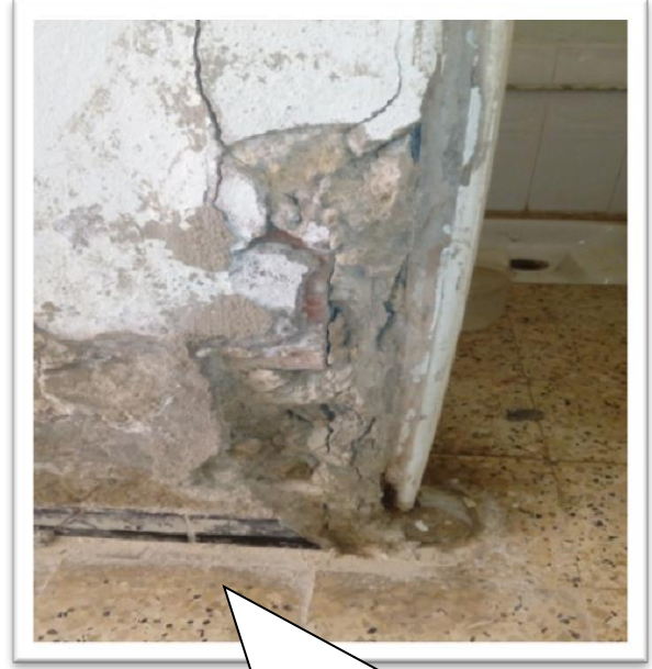
الصورة رقم (7-II): تآكل الخرسانة
