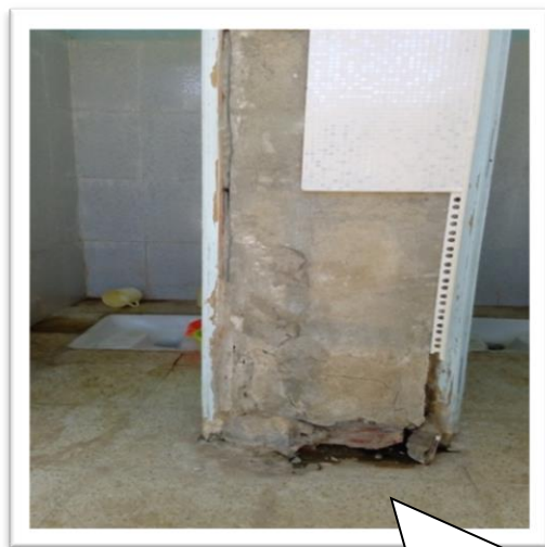
الصورة رقم (9-II): تلف تكسية دورة مياه مدرسة أول نوفمبر 1954 المخادمة
