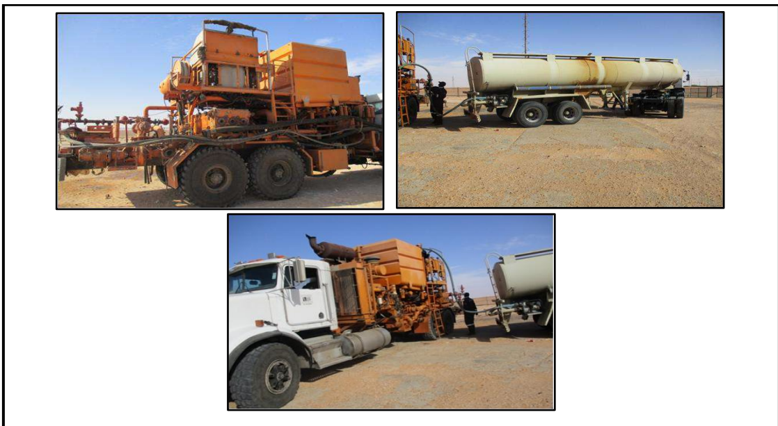
Figure III .1 : Unité de pompage et citerne de stockage de l'eau de désalage.
