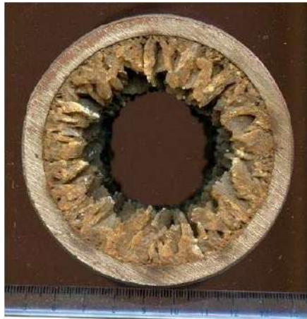
Figure II.2 : Dépôts de \text{CaSO}_4 dans une pipe de pétrole [6]
