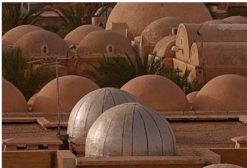
Figure I.17: Toiture en coupoles à Oued souf [4]
