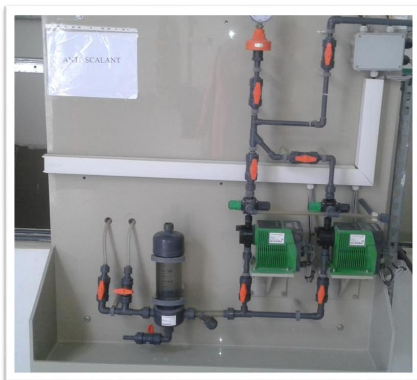
**Photo N°4: pompe injection d'antitartre (anti scalant)**
