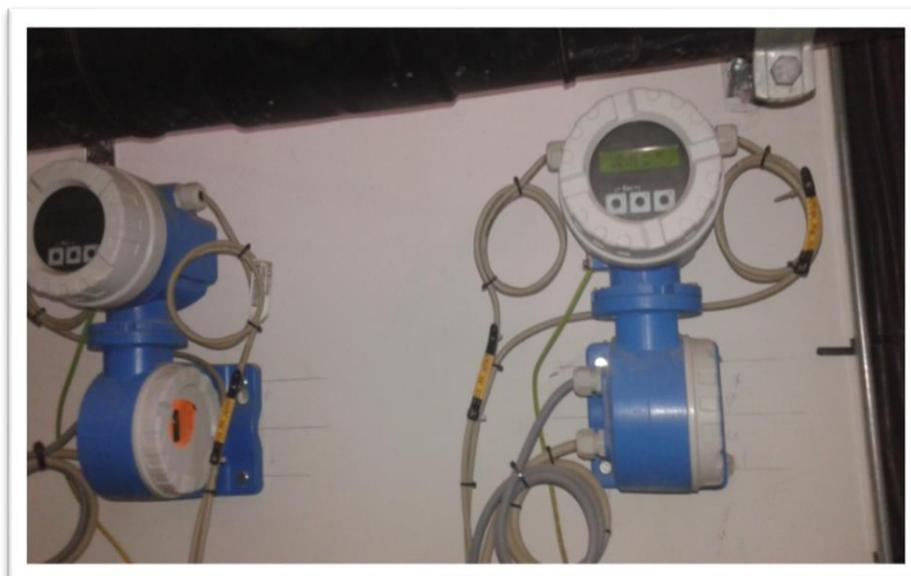
Photo II.1 : débitmètre électromagnétique
