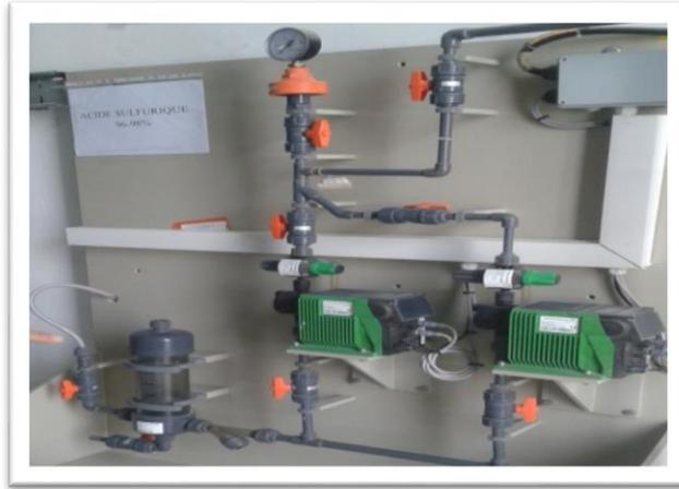
**Photo N°1 : une pompe d'acide sulfurique**
