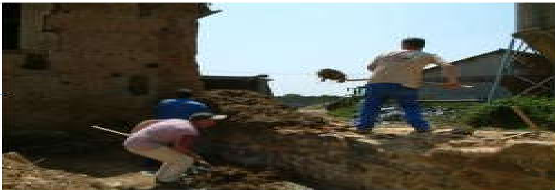
Figure I.14) : Mise en œuvre de la bauge [11].
