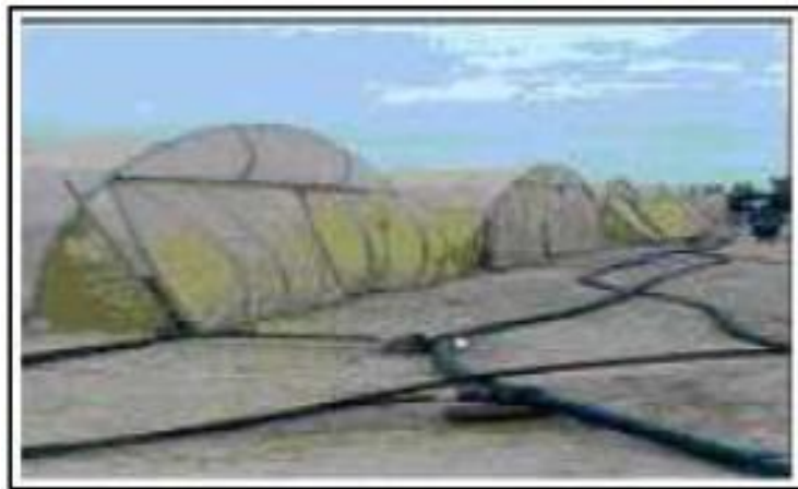
Figure I.2 : Chauffage des serres par énergie géothermique (Touggourt). [3]
