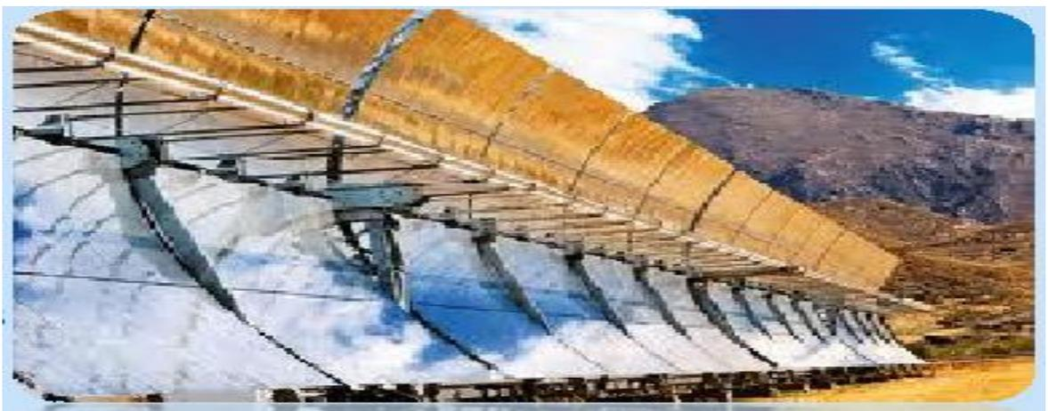
**Fig. I.5:** Centrale cylindro-parabolique [5]
