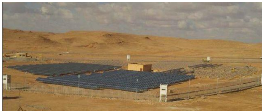
Figure III-1 : Installation photovoltaïque d'OUED NECHOU Ghardaïa.
