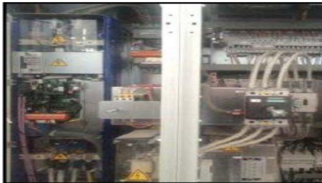
Figure II -19 : Onduleur de central PV.
