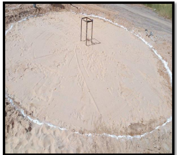
Fig.20: couche de sable 0.05 m
