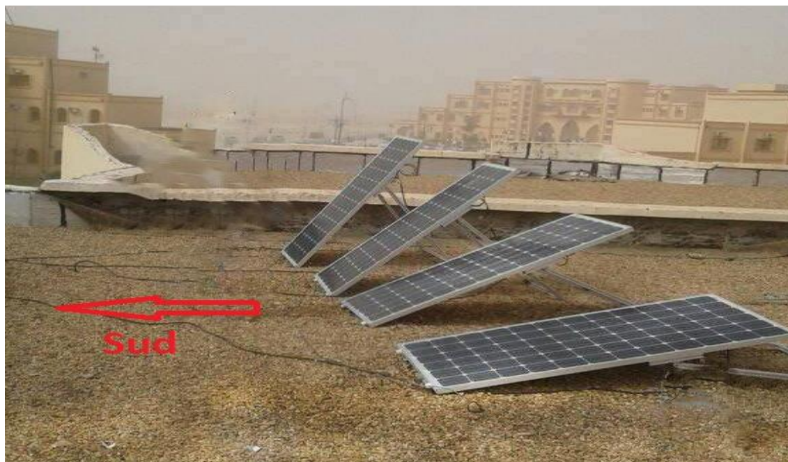
Figure III.1 : Disposition des panneaux solaire
