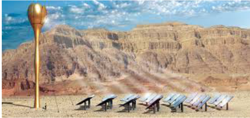
Figure I-10 : la tour de la centrales AORA.
