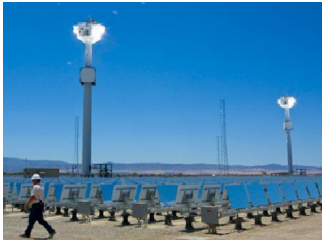
Figure I-11 : Les tours du module élémentaire Sierra Sun Tower
