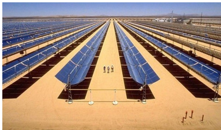
Figure I-13 : Les centrale cylindro-parabolique d'Ouarzazate (Maroc)
