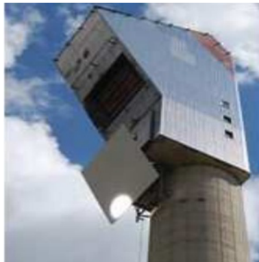
Figure I-7 : Le récepteur d'une centrale solaire à tour
