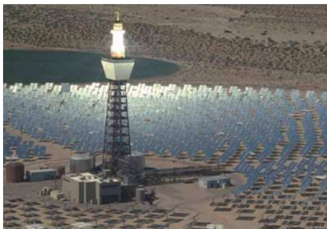
Figure I-6 : Tour solaire à effet de concentration
