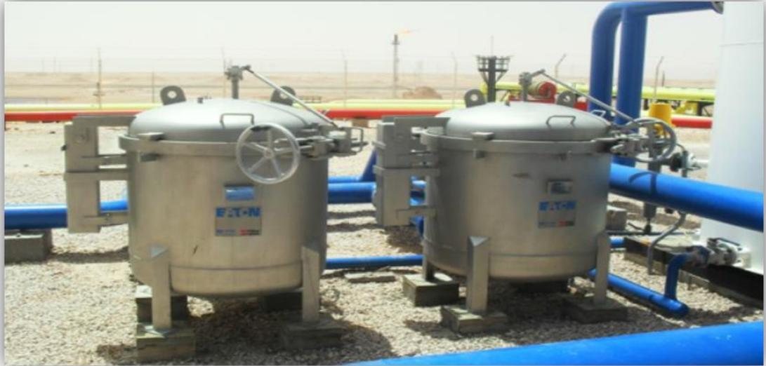
**Figure II. 12 : Schéma simplifié de filtre à poche [17].**
