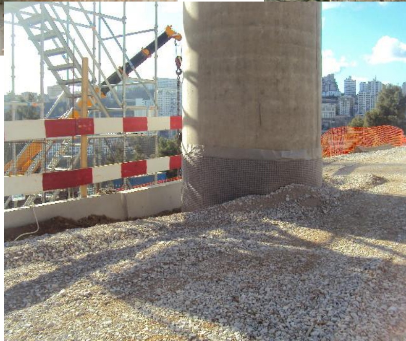
Drainage Culée de pont Constantine
