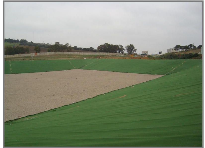
Drainage Eau et Lixiviat sur Géomembrane Tipaza
