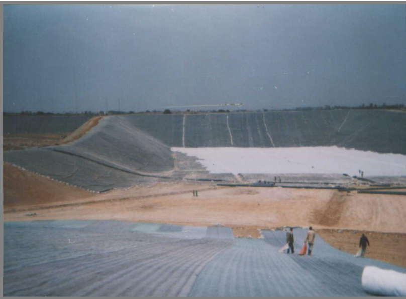
Drainage Gaz Sous Géomembrane Ouled Fayet
