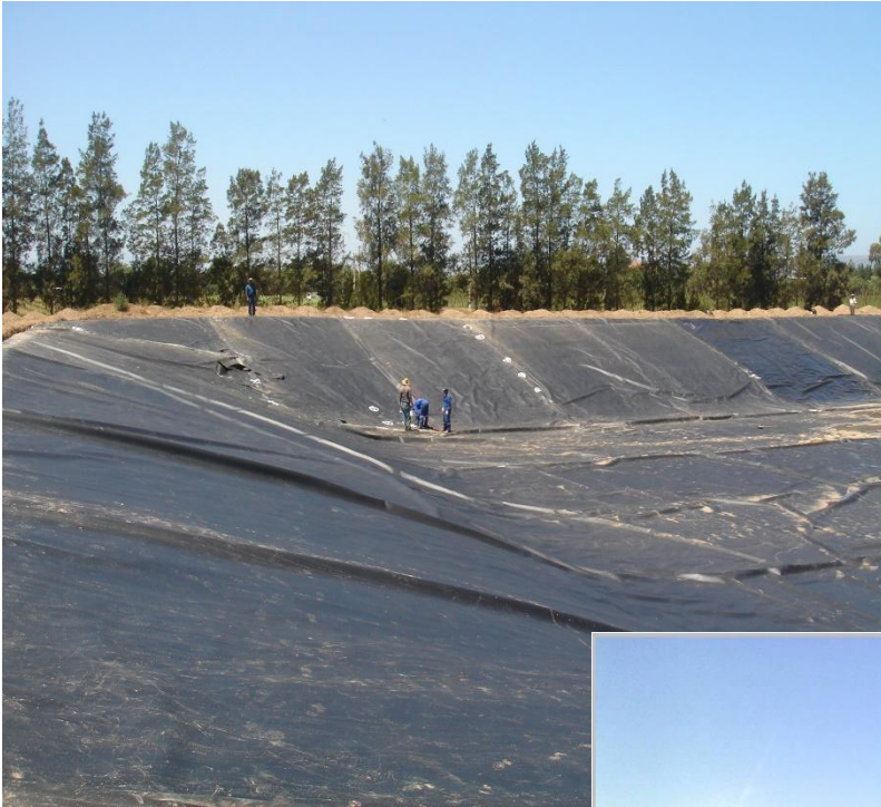
Etanchéité Bassin Stockage d'eau
