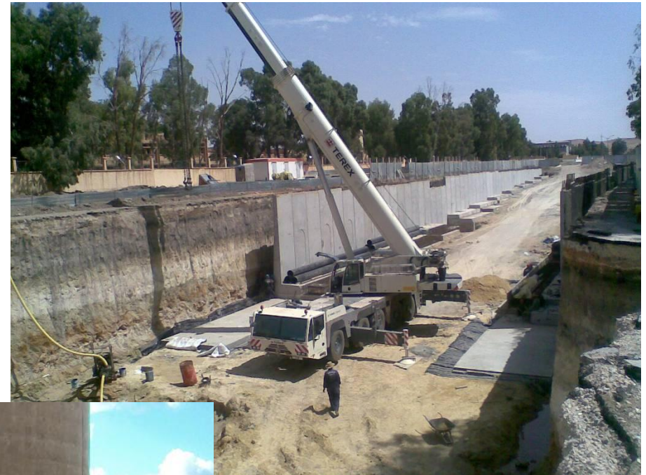
Drainage Sous Trémie Oum El Bouaghui
