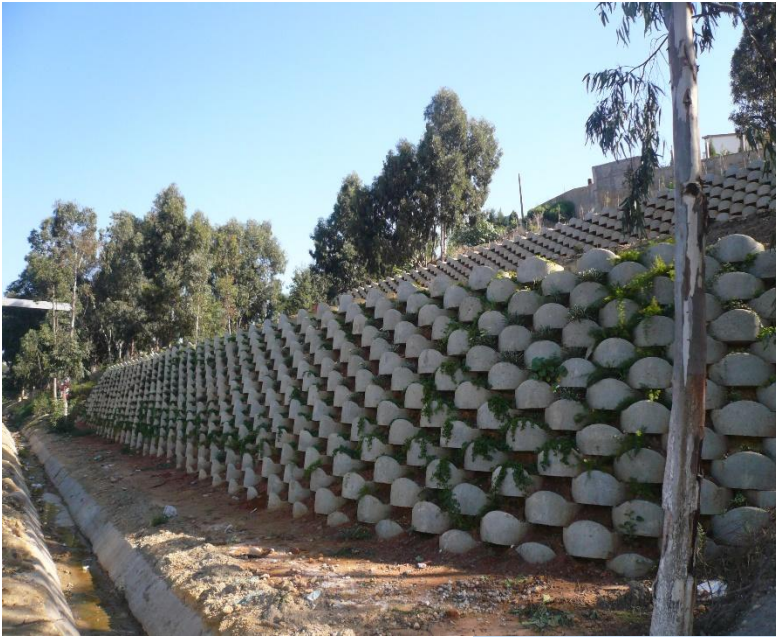
Traitement de glissement de terrain Alger
