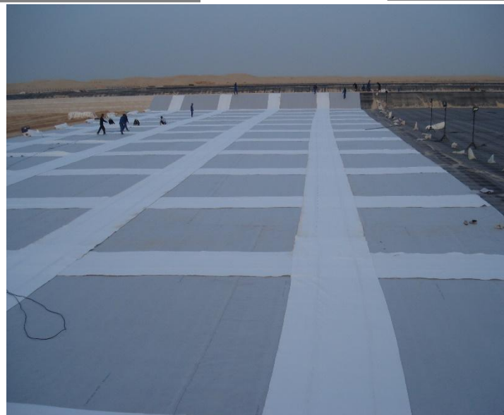
Drainage Gaz Sous Géomembrane STEP El Oued
