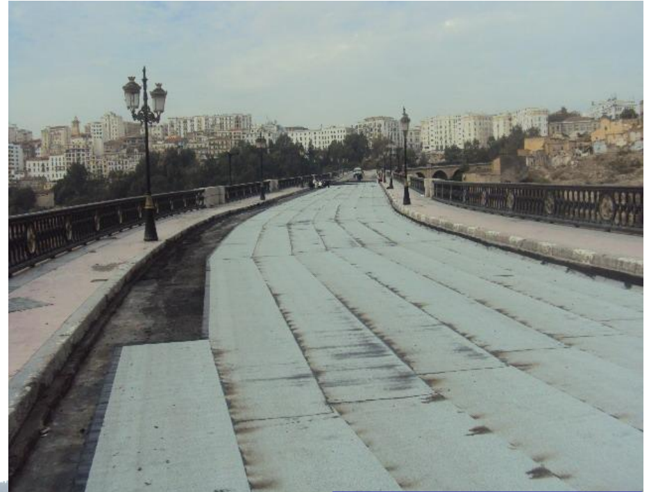
Etanchéité Ouvrage d'Art Constantine
