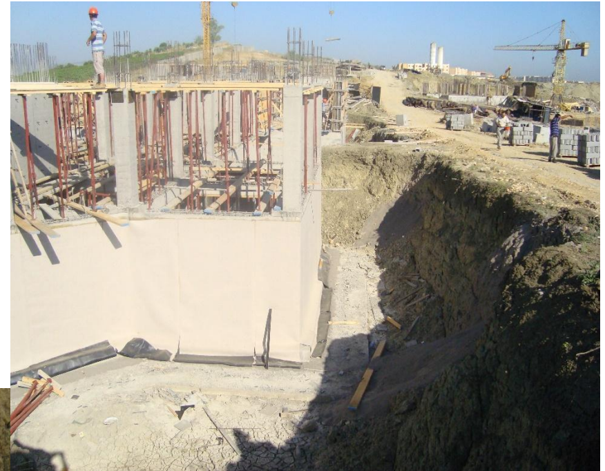
Etanchéité et Drainage de Sous sol
