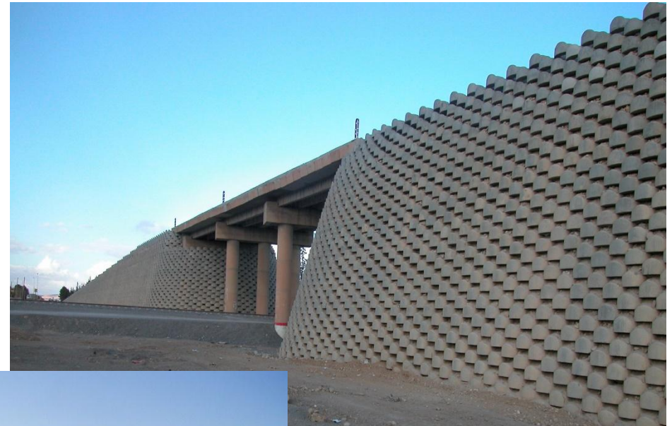
Rampe d'accès sur ouvrage d'Art M'sila
