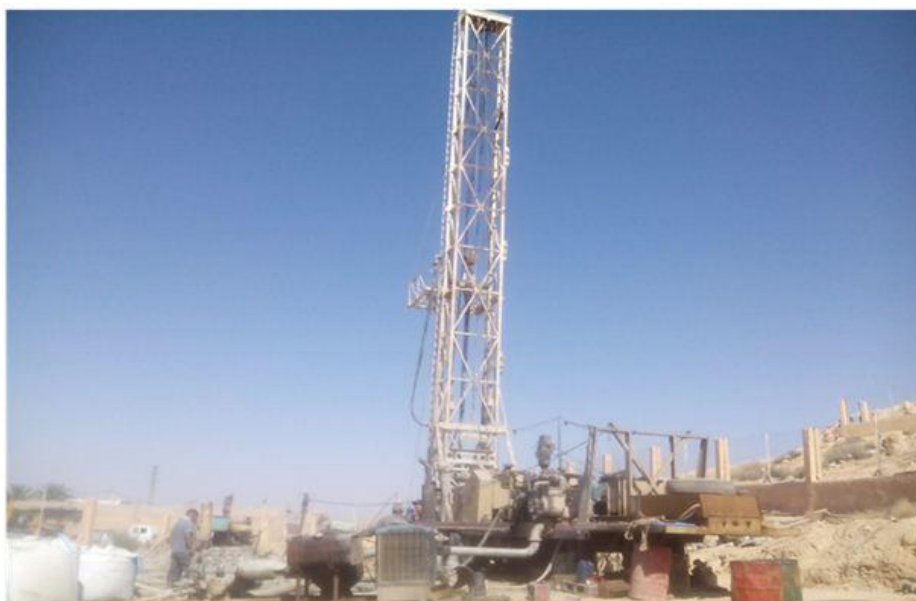
Photo. II.2. Le mat de forage.
