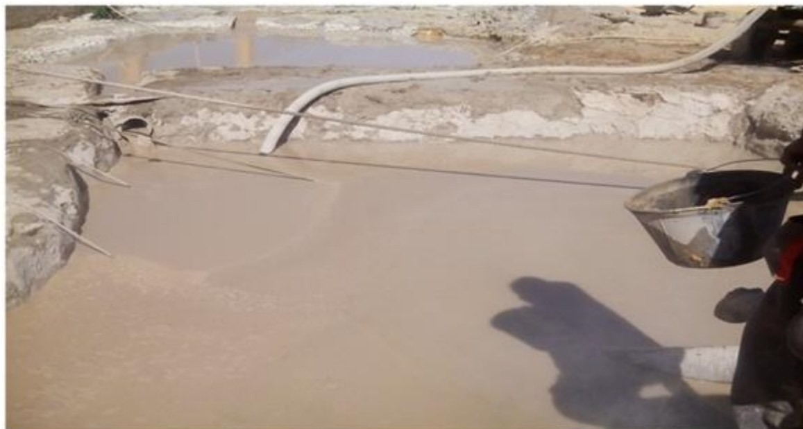
Photo. II.13. La fosse à boue utilisée dans la réalisation de forage.
