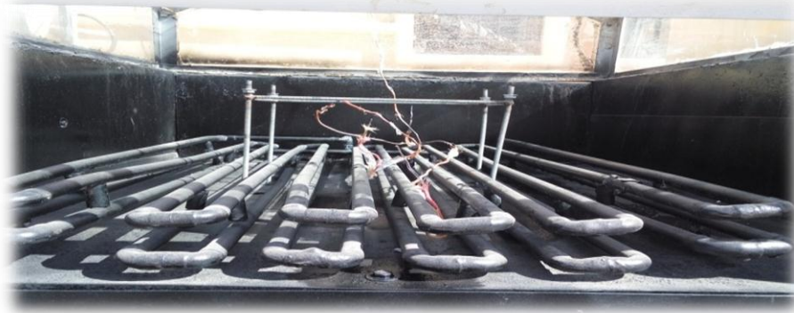
Figure III.4 : Emplacement de l'échangeur
