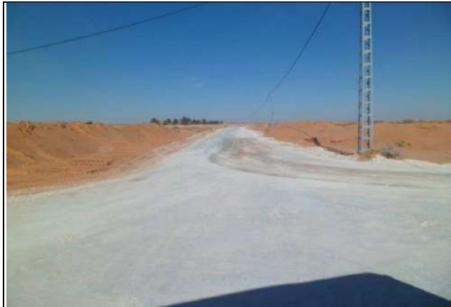
Photo n° 31: piste agricole après achèvement des travaux.
