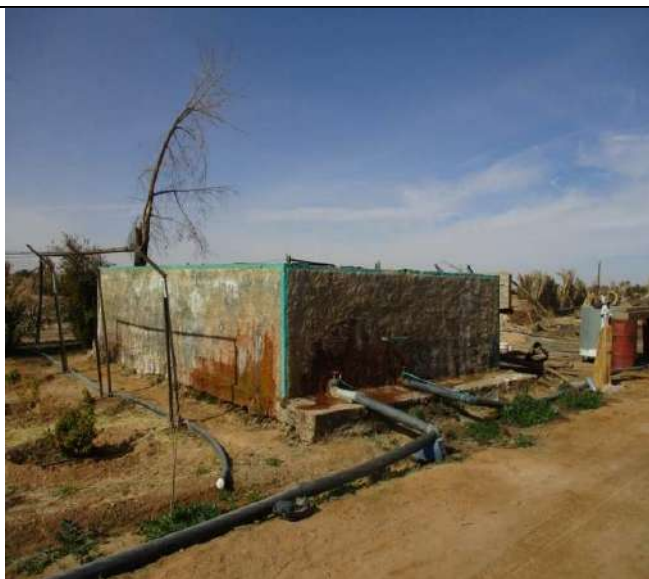
Photo n° 71: Bassin d'accumulation réalisé dans le cadre de la concession ( kchemi Errih- Ouargla)
