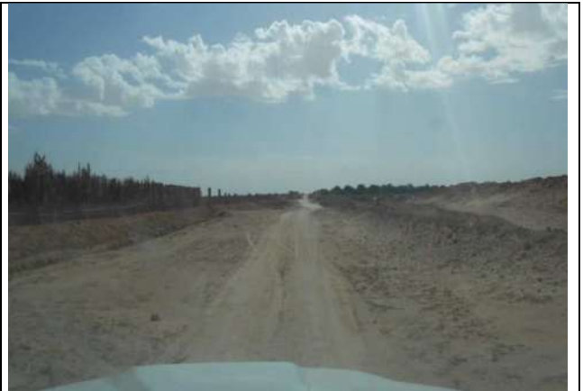
Photo n° 32 piste agricole après 5 ans (dégradation et ensablement).
