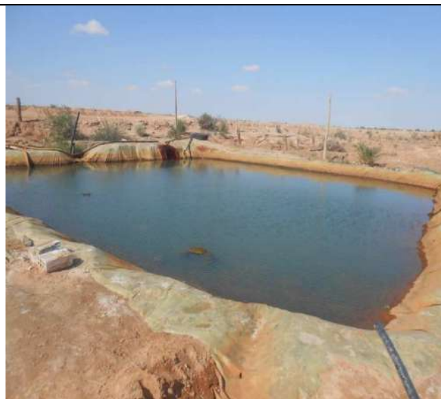
Photo n° 72 : Bassin d'accumulation construit par la les bénéficiaires
