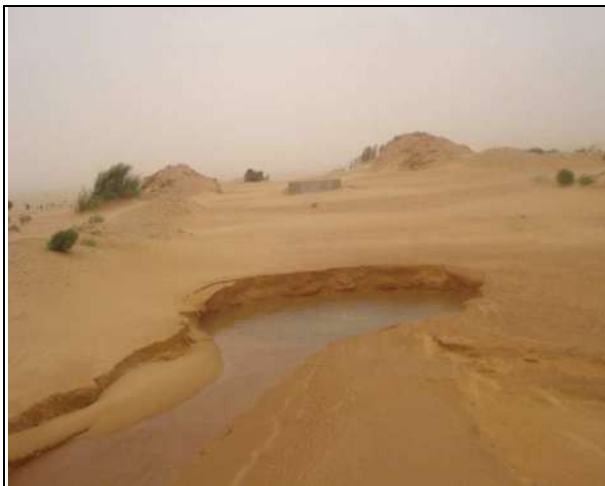
Phot n° 39 : fuite dans la conduite du réseau d'irrigation de khchem Erih II
