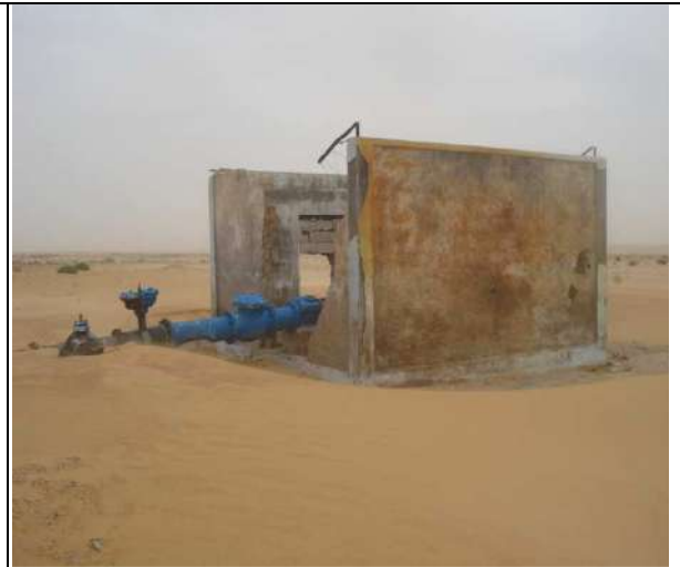
Photo n° 26 : abri pour forage albien
