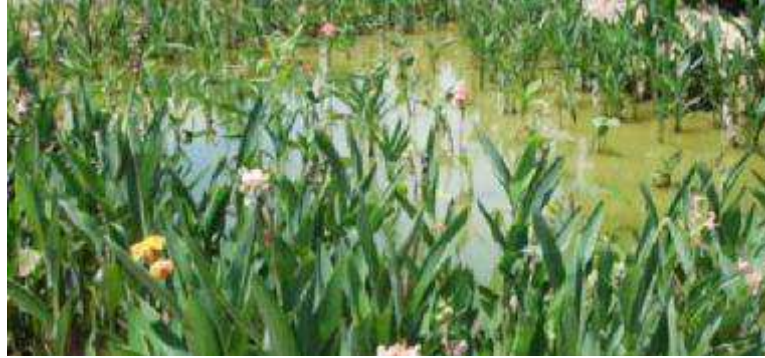
شكل (05): محطة معالجة النباتات ذات الجريان السطحي الحر ( FWS ) مغروسة بنبات القصب ( Phragmites australis ).
