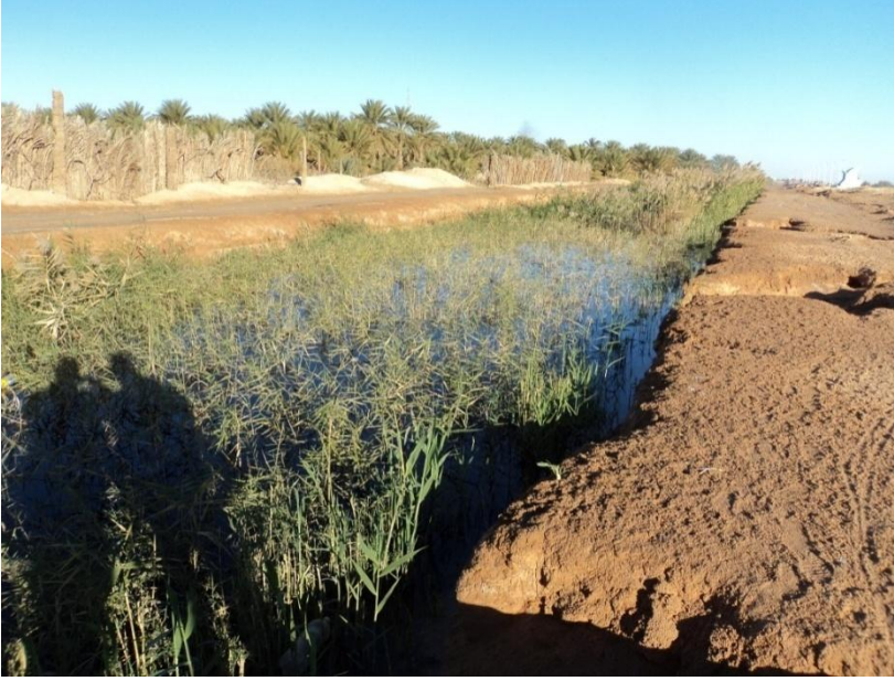
صورة 05 : تآكل وانحيار جدران القناة الرئيسية لوادي ريغ - منطقة عين الشوشة
