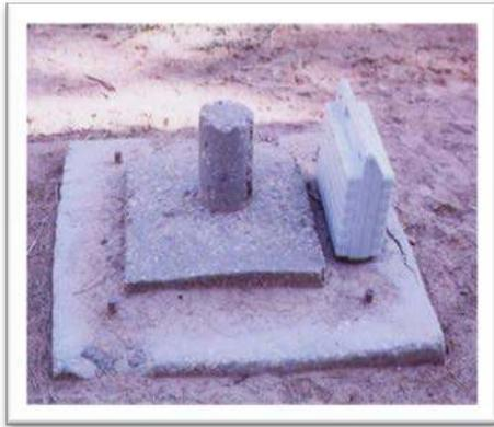
Photo.9 : un forage du CT bouché à Ranou.
