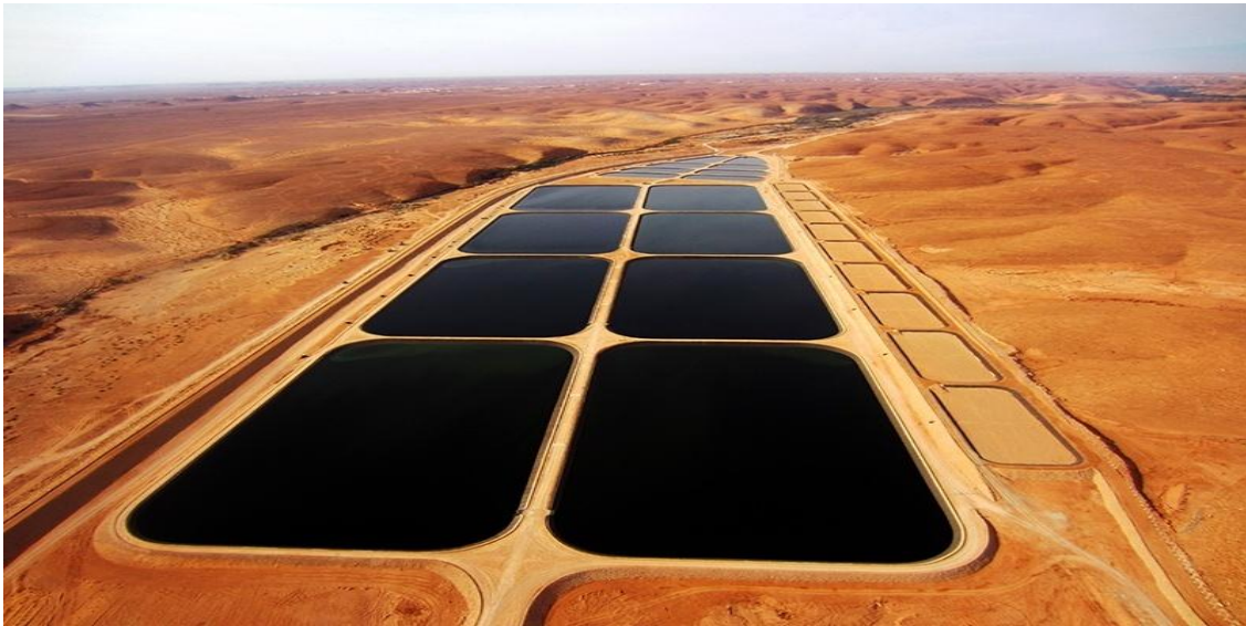
Photo 1.2. Station d'épuration de Ghardaïa lagunage Naturel
