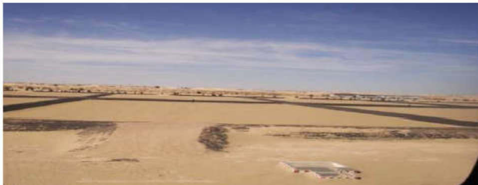
Photo 06. Lits de séchage des boues
