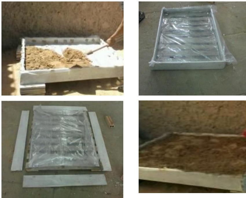
Figure 5.8 : Les matériaux utilisés et les étapes de construction de la toiture végétale.
