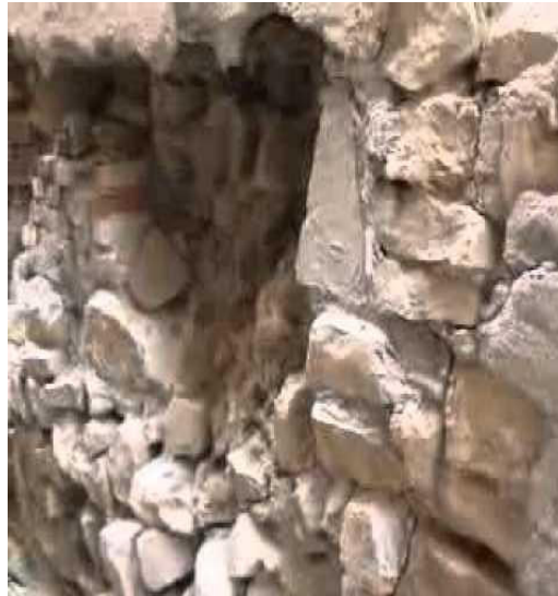
Figure 3.3: Usage de matériaux locaux (la pierre) à Ouargla
