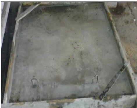
Figure5.5 : Collage de la dalle.
