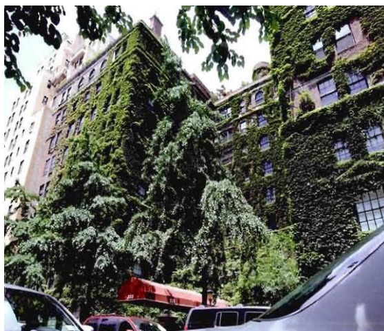
Figure 3.24 : Façade végétalisée recouverte de plantes grimpantes. New York, 2009(Bernier A,2011).
