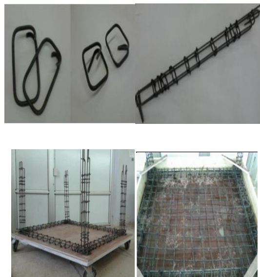
Figure 5.1: Préparation de ferrailage.
