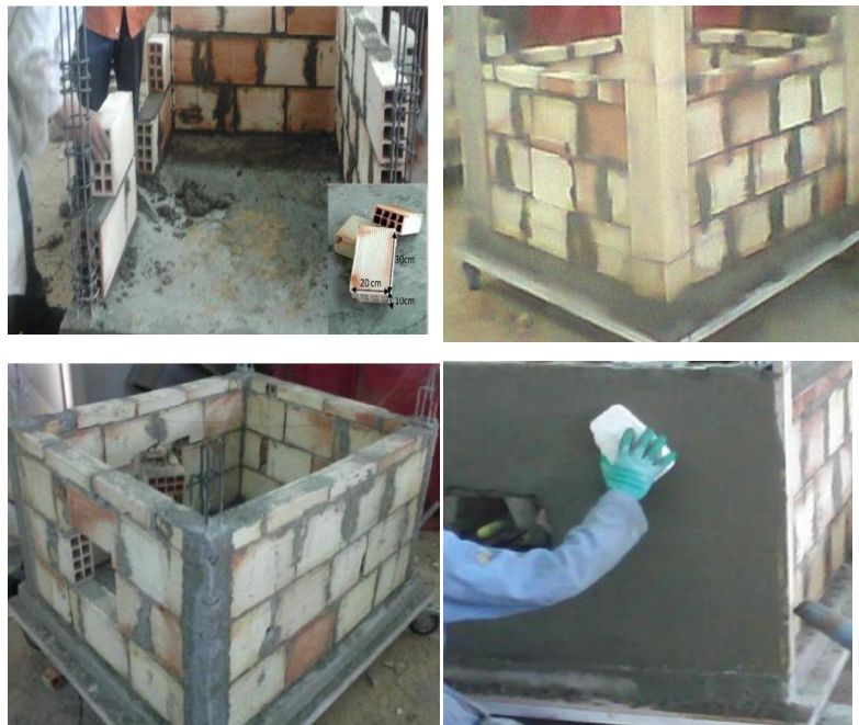
Figure 5.2. Construction de l'enveloppe.
