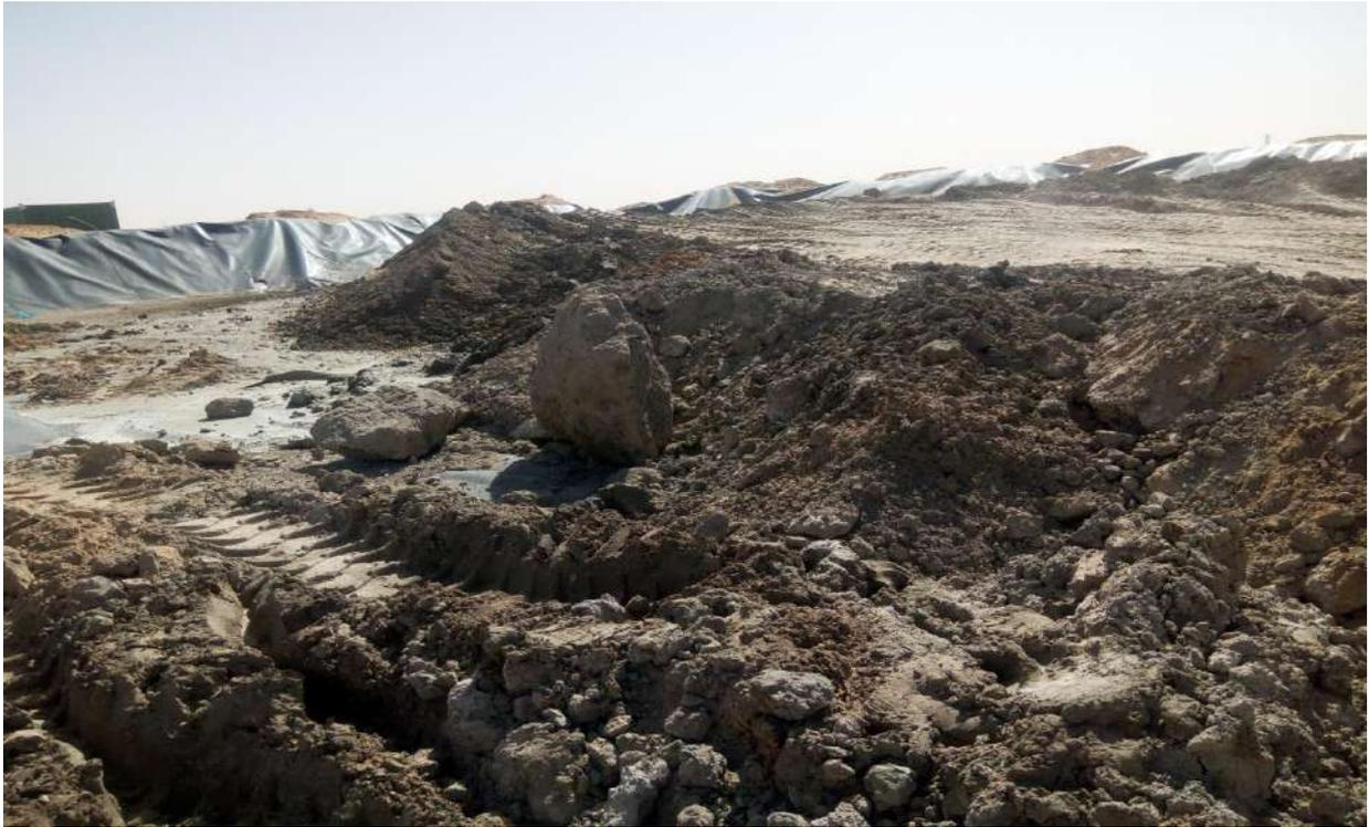
**Figure 19 : bourbier de forage MD660 après traitement in site**
