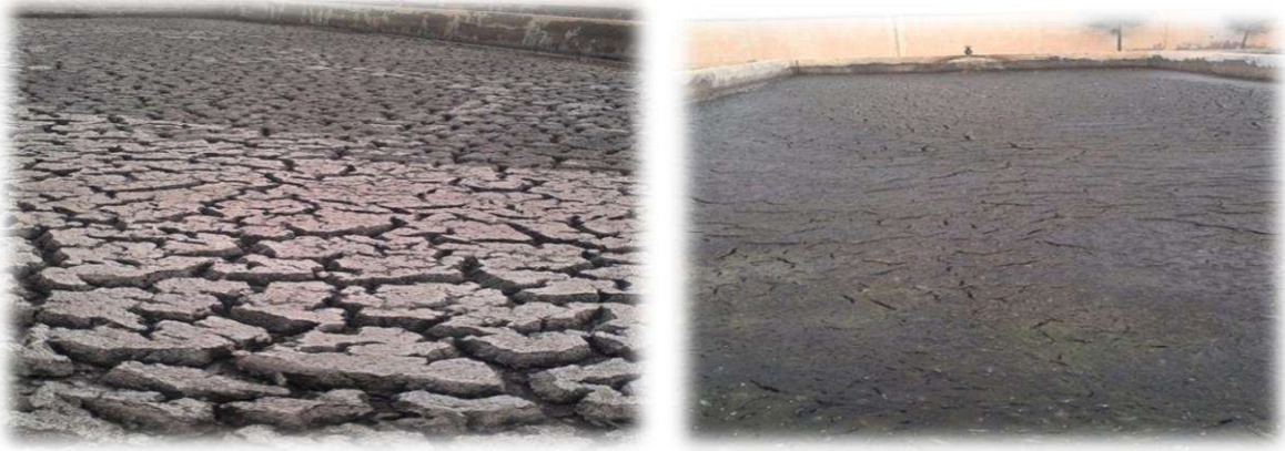
الشكل (14) أحواض التجفيف
