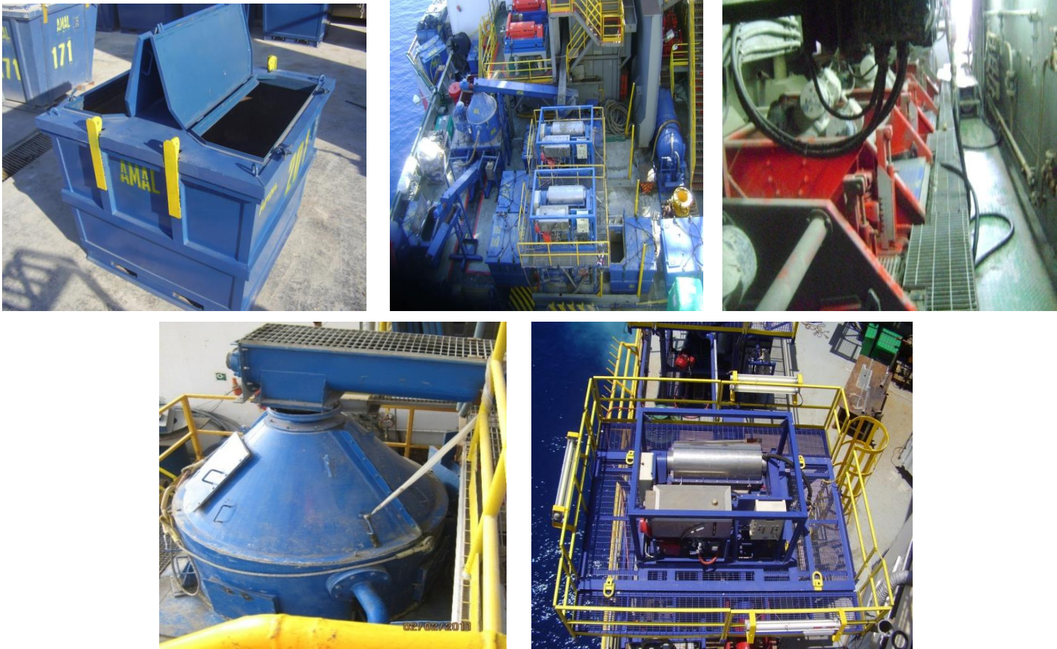
Fig.32. les équipements de traitements des déchets en ligne. [32]
