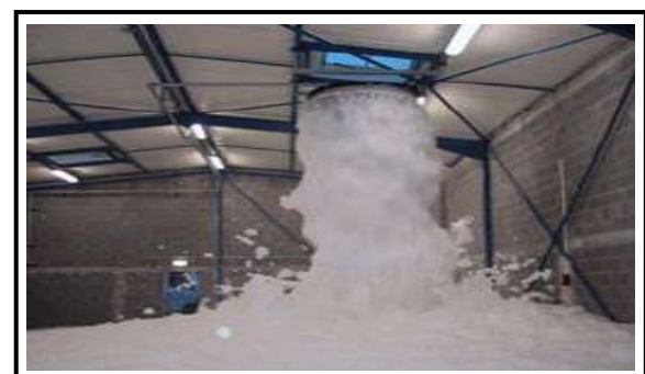
Figure 1.24 : Mousse haut foisonnement dans un local
