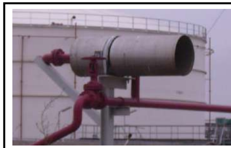
Figure 1.23 : Générateurs moyen foisonnement
