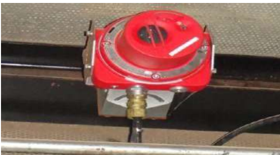
Figure 2.7 : Détecteur de flamme à ultra-violet
