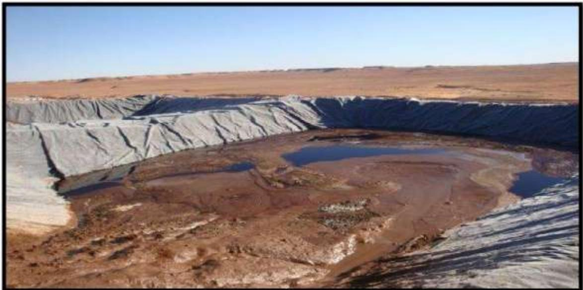
Figure(2.7): bourbier conventionnel (volume =3800m<sup>3</sup>, liner de mauvaise qualité )
