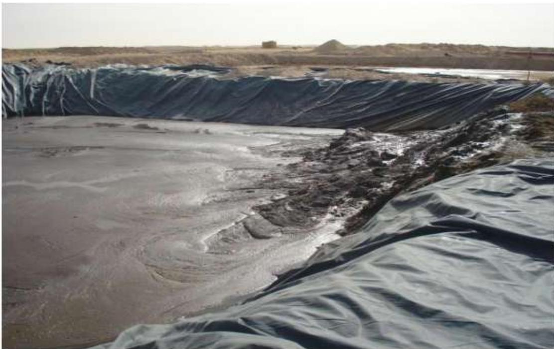
**Photo (2.3) :** Site de stockage des boues de forage
