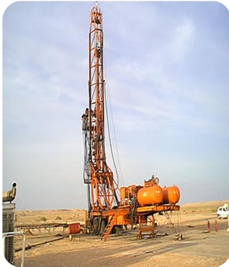
Figure 9 : Unité autonome à vérin –câble (TYPE: HYDRA RIG LONG STROKE-HRL-)
