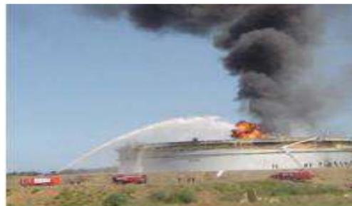
**Figure 06 :** Envoi d'eau/mousse dans un bac en feu, par les équipes d'intervention
