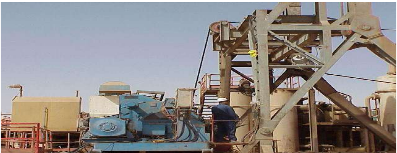
Fig. 7: Descente de treuil
