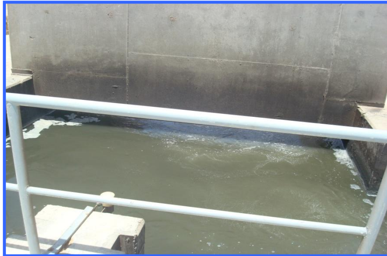
Photo N°13 : L'entrée des eaux usées à la station.
