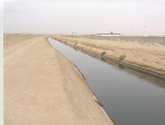
Photo n° 07. Drain principal côté Ouest
