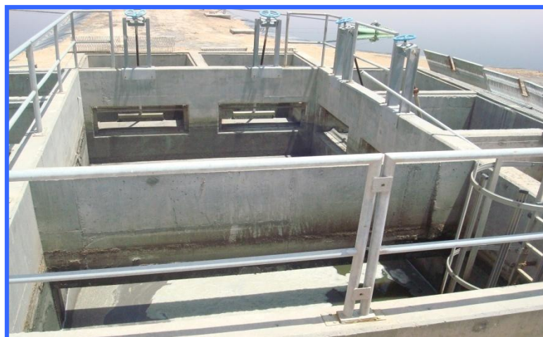
Photo N°16 : Répartiteur vers les bassins d'aération.
