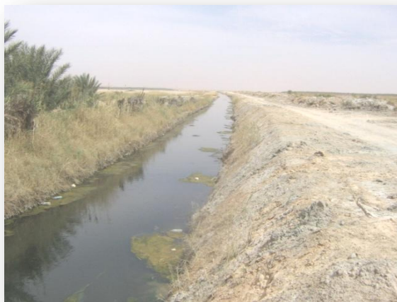
Photo n°06. Drain principal côté Est
