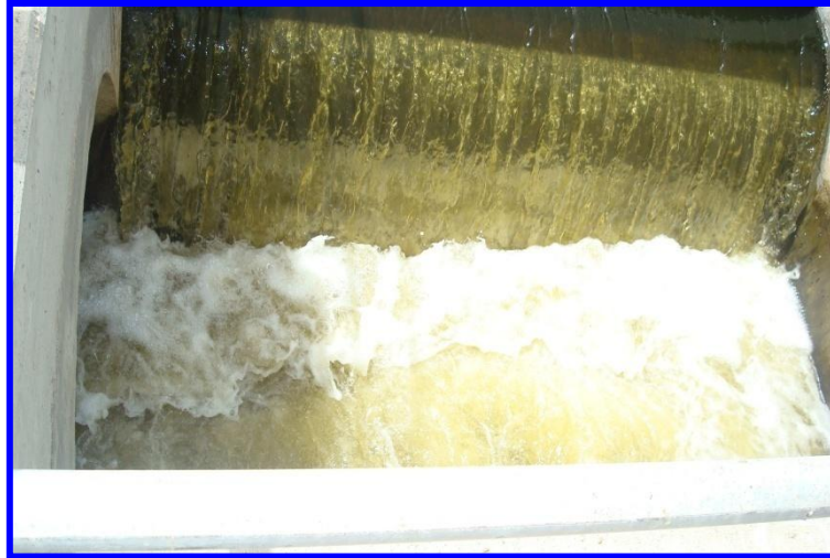
Photo N°18 : La sorties de l'eau traitée.
