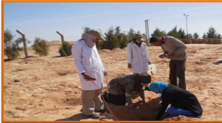
Photo N°11 : Homogénéisation des diamètres des trous destinés à la plantation.
