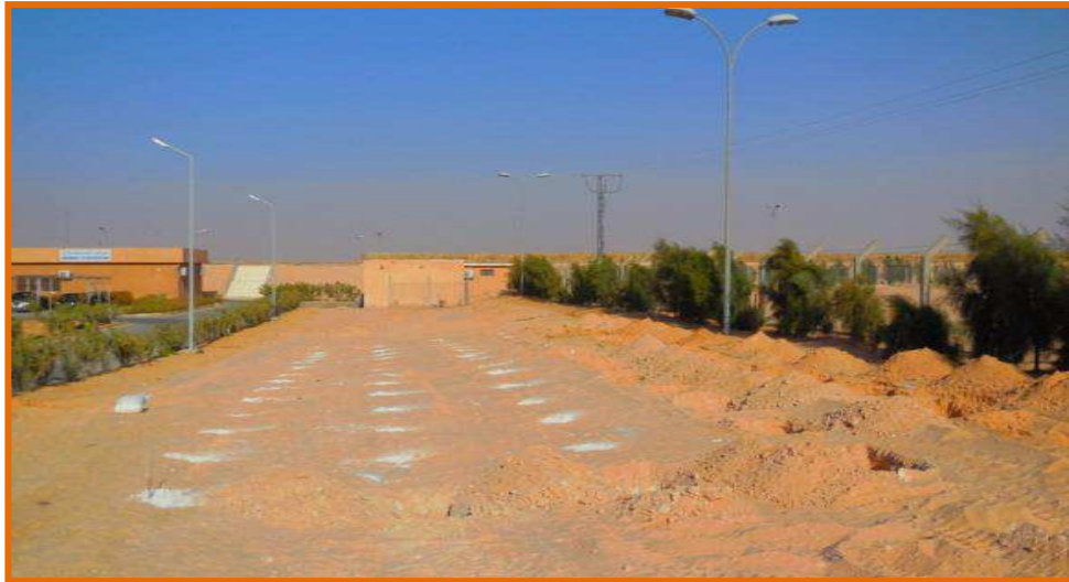
Photo N° 08 : Marquage avec de la chaux des emplacements de chaque plante à l'aide d'un décimètre.
