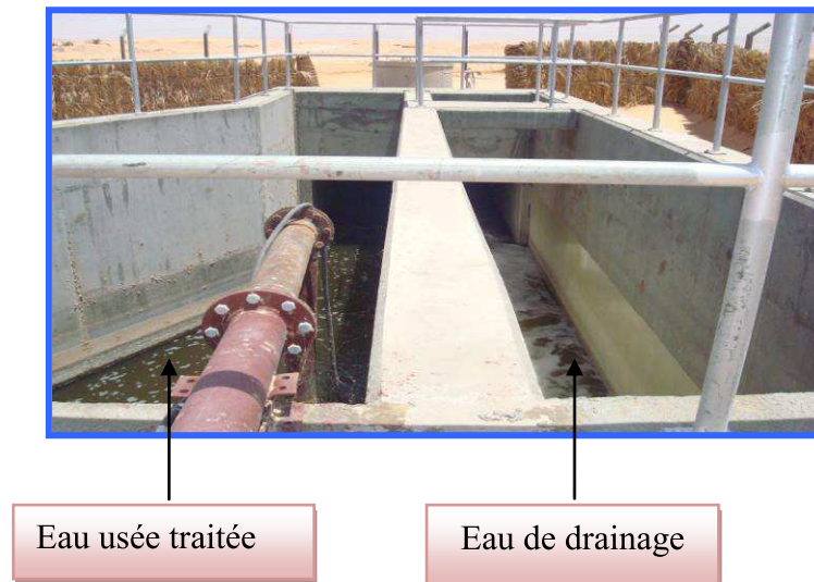
Photo 01: Composantes du canal de transfert des eaux usées traitées et des eaux de drainage vers Sebkhath Sefioune.
