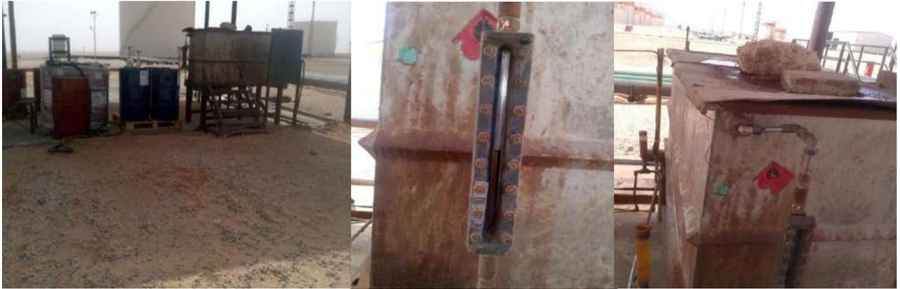
**Figure 19 :** Station d'injection des produits chimiques.
