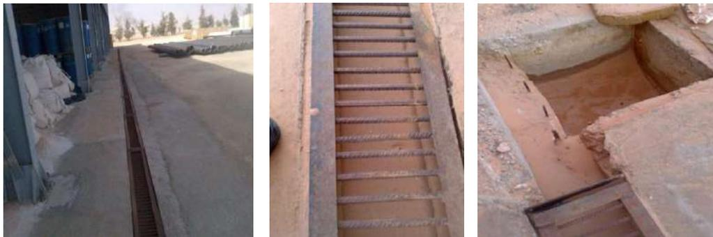
**Figure 16 :** Cuvette de rétention.
