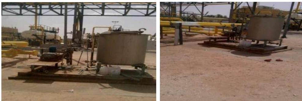
**Figure 21 :** Station d'injection de CHIMEC 1038.
