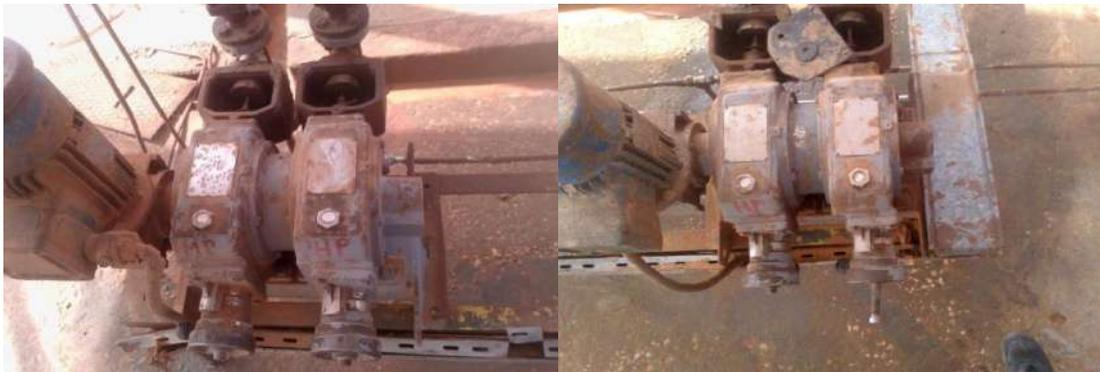
**Figure 20 :** Pompes à piston.
