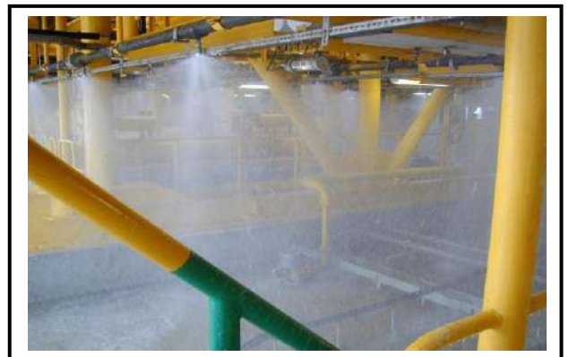
Figure 1.11 : Système déluge en fonctionnement
