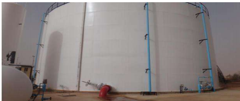
Figure 2.16 :Bac FB204 d'eau incendie de capacité globale de 5300 m 3
