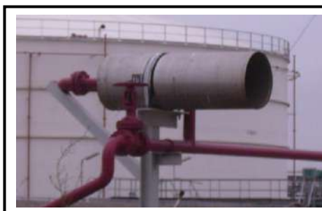
Figure 1.23 : Générateurs moyen foisonnement
