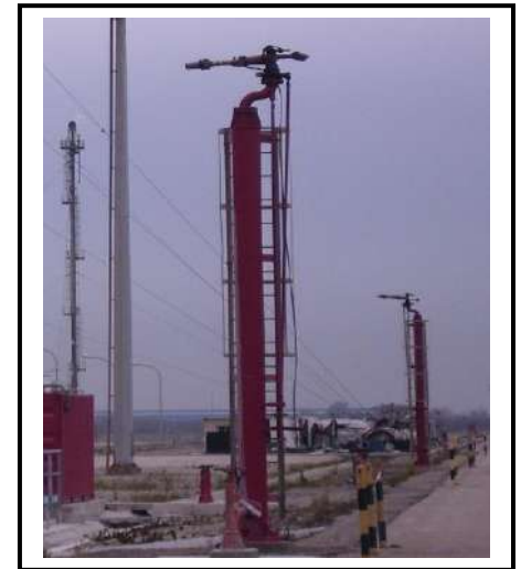
Figure 1.18 : Espacement des lances monitors, positionnées en hauteur
