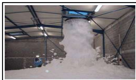
Figure 1.24 : Mousse haut foisonnement dans un local
