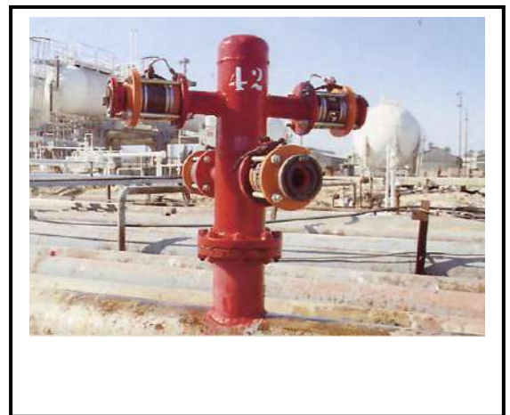
Figure 1.16 : Poteaux de type mécano-soudé
