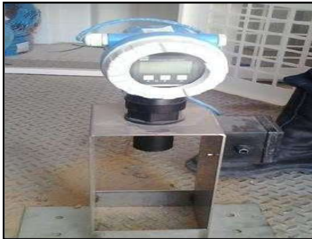
Figure.11: Capteurs de niveaux de bac
