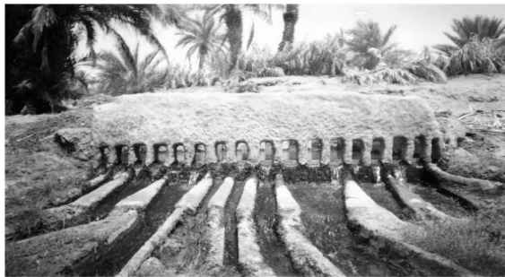
Photo.1 : Kasria secondaire de la Foggara d'EL Meghier (Remini, 2000)
