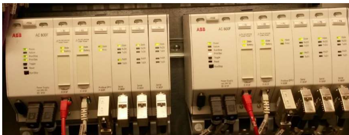
Fig. II.2:Automate ABB AC 800F.
